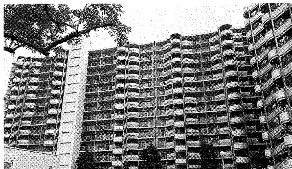
階段が非常に多いスキップフロア型マンション
