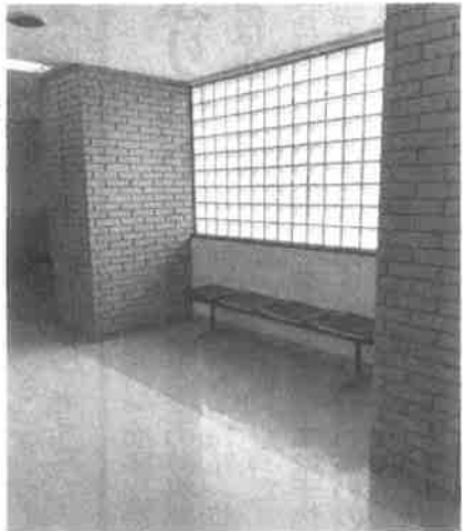
廊下のガラスブロック
