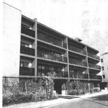
緑がフェンスと1階を隠す
