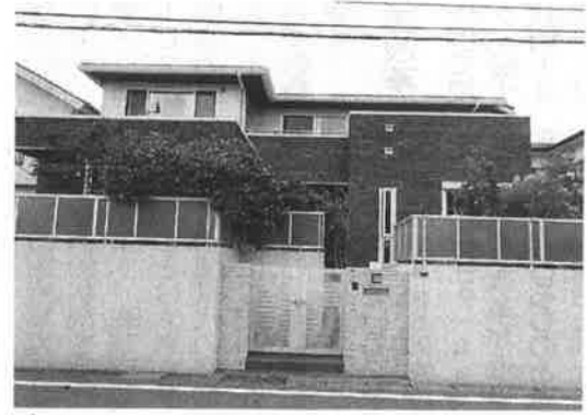
門扉から玄関が見えない住宅を発見したが...
