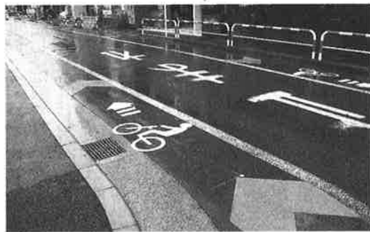
自転車に車道を走るよう促す路面表示
