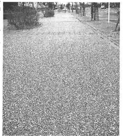
洗い出し仕上げの歩道
