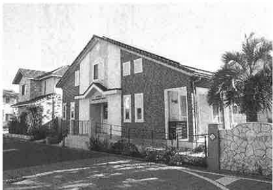
大型分譲地内にできたスマート集会所
