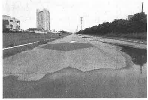
地域を分断するほど広い空き地状の道路用地
